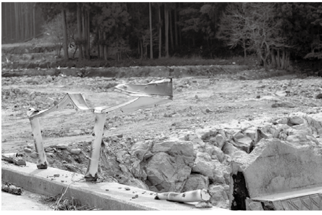
㉞被害が大きかった滝地区。猛烈な濁流にガードレールが激しく変形
