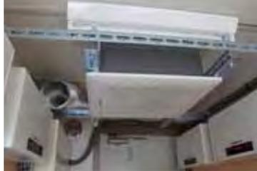
出力195Wの太陽光パネル24枚（4.6kW）に対してパワコン1台を接続（合計9台が稼働）。熱をもつので建屋のなかにはエアコンが設置されている（もちろん、このエアコンは発電した電気動く）
