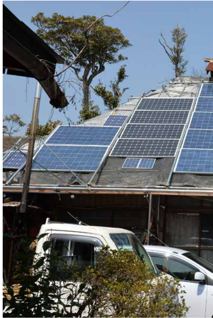
曾祖父が建てた築100年余の茅葺き家に載せた数々のソーラーパネル。世界でも唯一の風景に違いないと自負。パネルにはジョイントをつけて斜面の足場パイプとつないだ。自転車はオブジェ。パネルからELワイヤーを這わせて夜は光るようにした 写真=森住 卓
