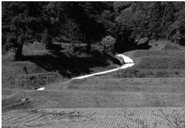
山際の農道は、2年前に直営施工隊がコンクリートで舗装したところ
