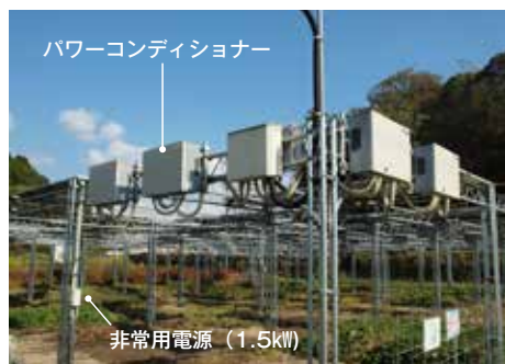
パワーコンディショナーで直流を交流に変換して電力会社の系統に連系。支柱には1.5kWの非常用電源のコンセントが付けてある
