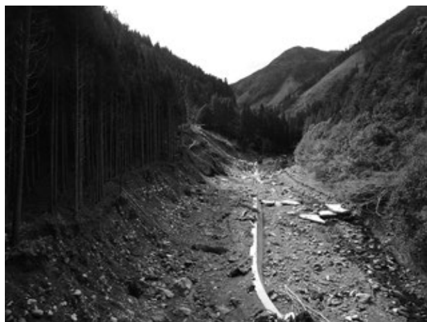
間伐されずに放置された人工林（左側）が、災害前は中央の白い擁壁（一部が倒れている）まで連なっていた。川の増水で水位が擁壁を越えたことにより樹木が根こそぎ倒れ、下流へ流された（球磨村川島の楮木川）
